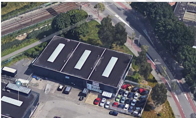
Figuur 2 – Dak voor “Zonnepark Eindhoven Doornakkersweg 10-14”
